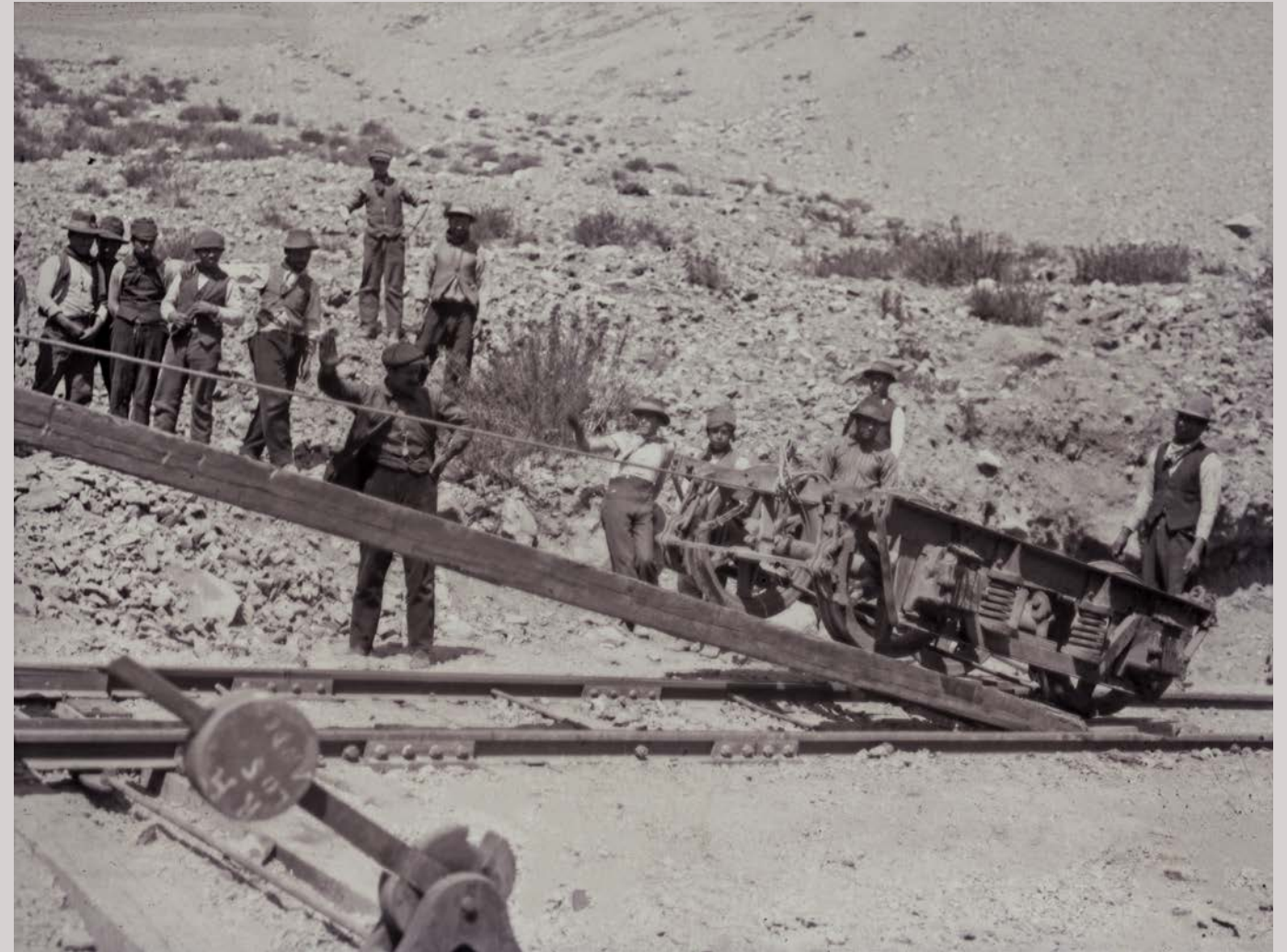
TÍTULO: Faena de montaje de un boggie en las vías del FFCC Trasandino. PROPIETARIO: Alicia Fishwick Tapia AÑO: 1915 aproximadamente LUGAR: Los Andes
