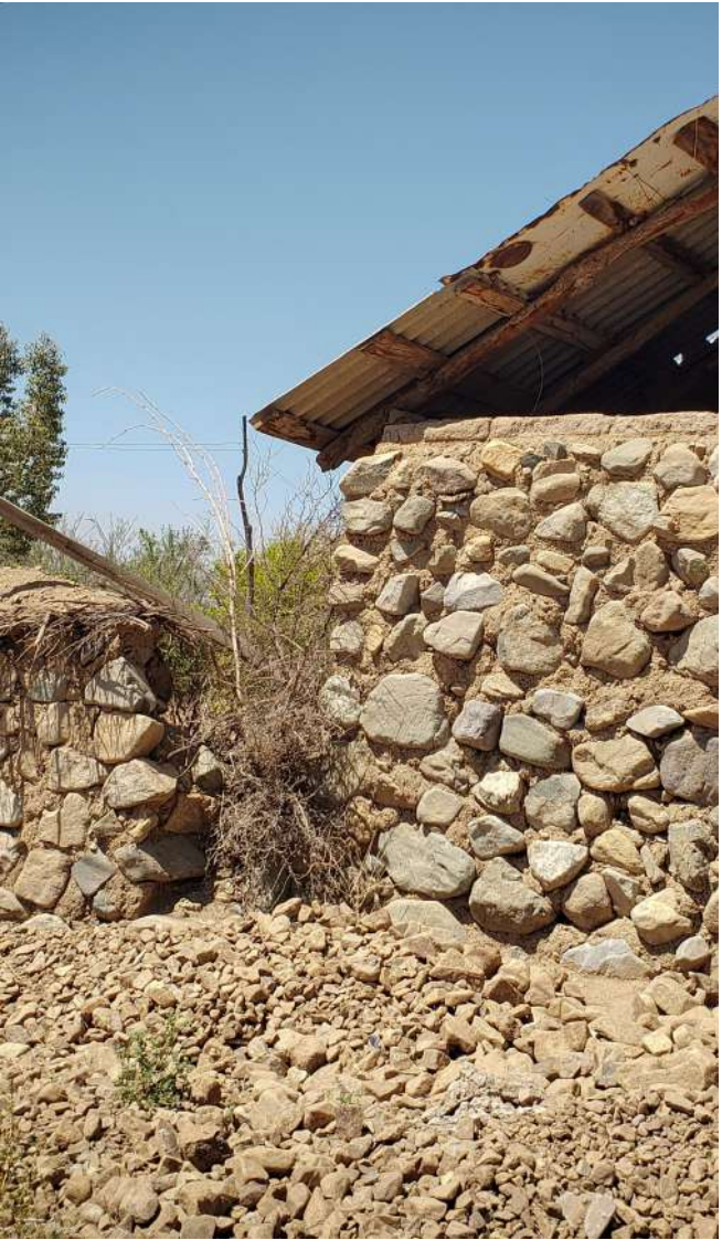
Figura 41. Galpón con muro de piedra, 2021.
