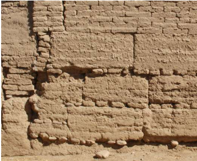
Figura 39. Muro con barda en teja de arcilla, 2021. Figura 40. Muro de tapial y albañilería en adobe, 2022.
