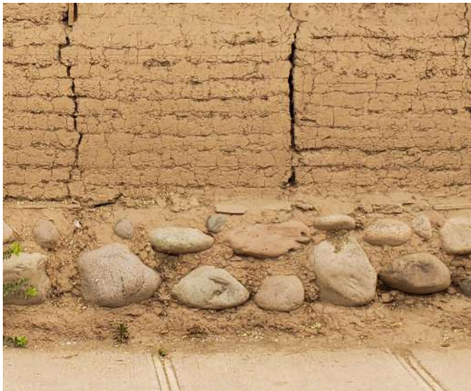
Figura 42. Pirca con argamasa de barro, 2022. Figura 43. Muro de tapial con basamento de piedra, 2022.
