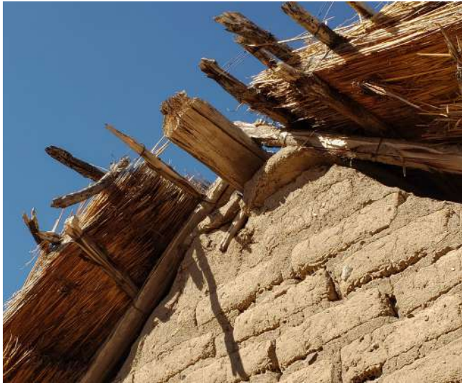
Figura 37. Muro de albañilería en adobe, 2021. Figura 38. Detalle de techumbre en madera y coirón, 2022.
