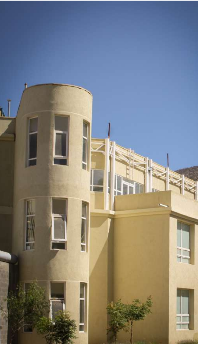
Figura 60. Hospital Psiquiátrico de Putaendo, 2022.
