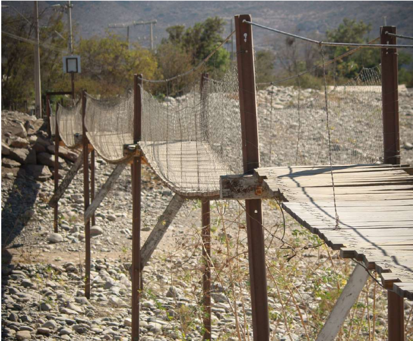
Figura 57. Puente de Cimbra, 2022.
