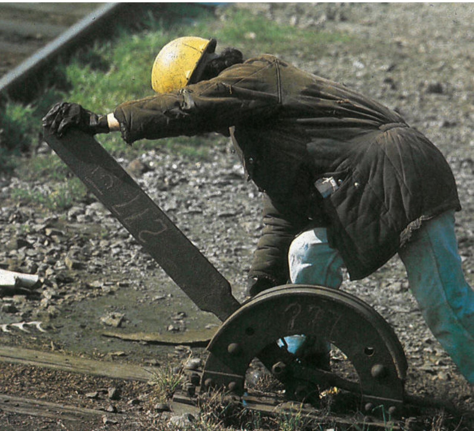
*Ilustración 5 - Labores del palaquero realizando el cambio de vías.*
