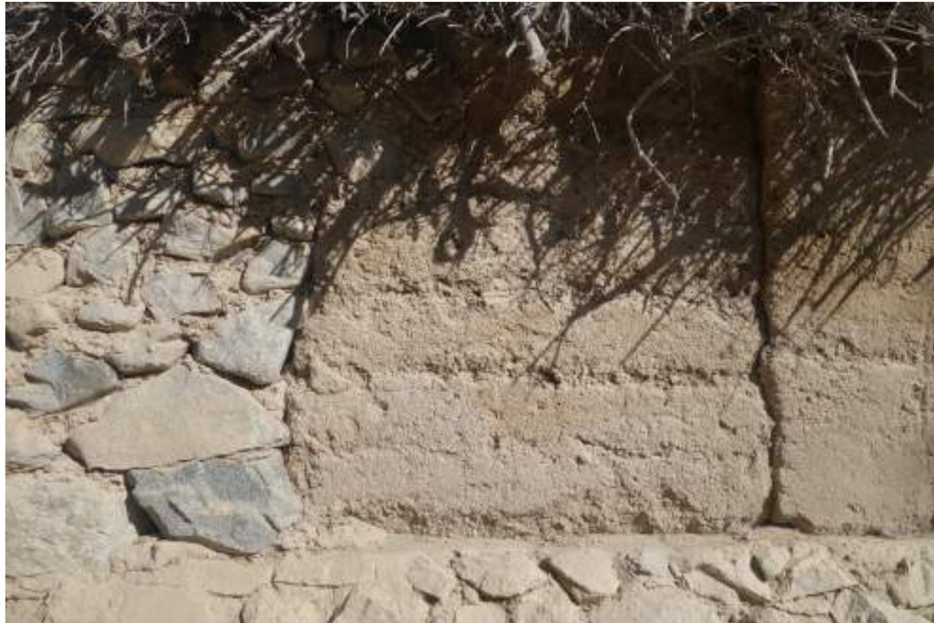
Fig 02. Detalle muro de adobe, Las Mollacas, 2019.
