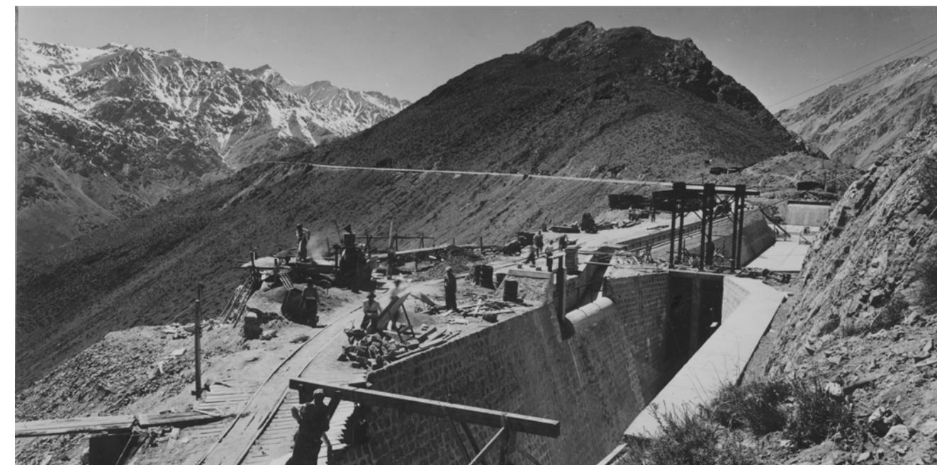
Fig 30. Cámara de carga de la Central hidroeléctrica Los Molles, 1950 ca.
