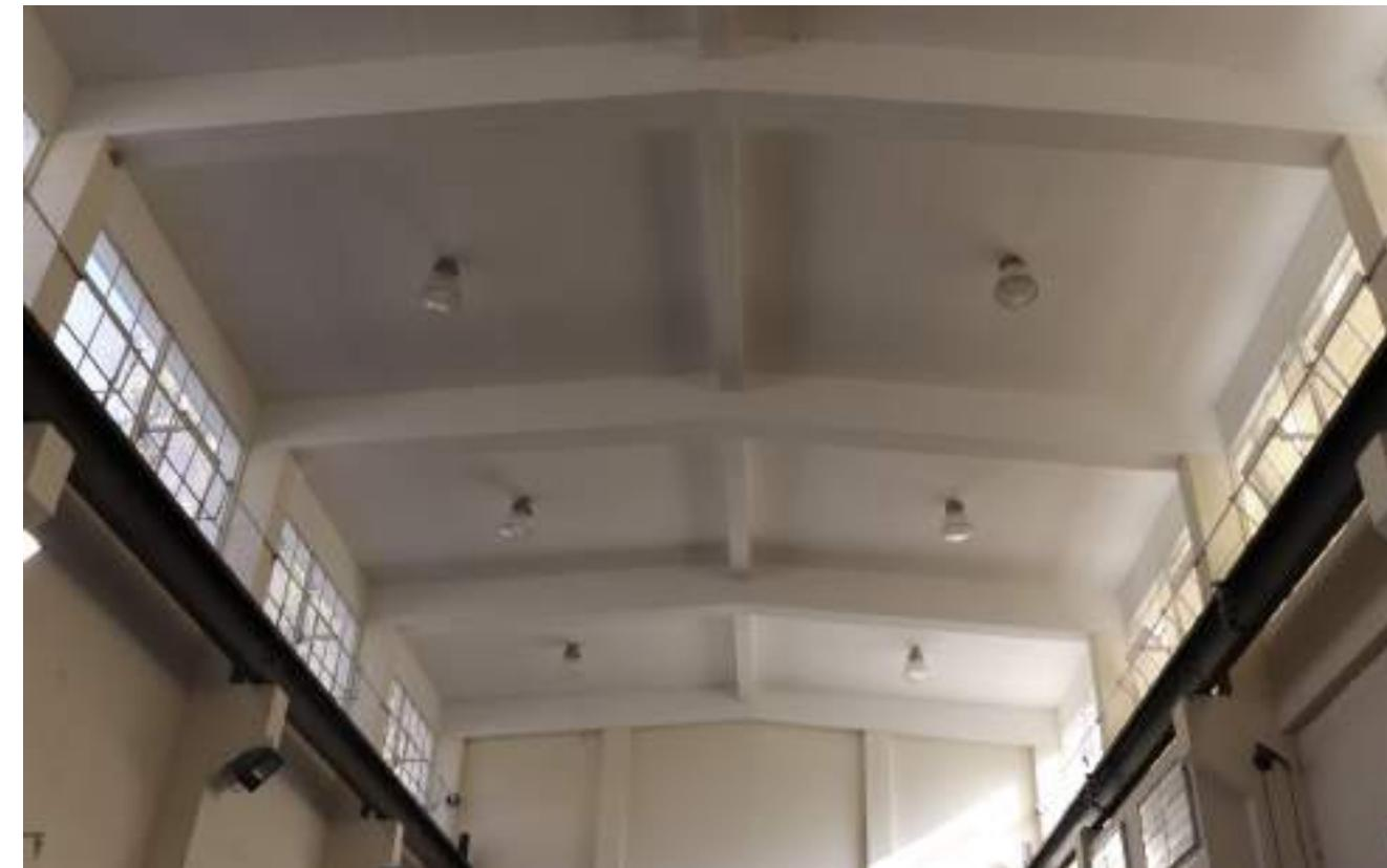
viga metálica y un puente. En este caso aparece sin embargo una viga central. Otro elemento en común con la mayoría de las centrales es el uso de la iluminación cenital a través de ventanas con marcos de fierro y cristales, siendo la fachada del costado muy similar a Cipreses.
