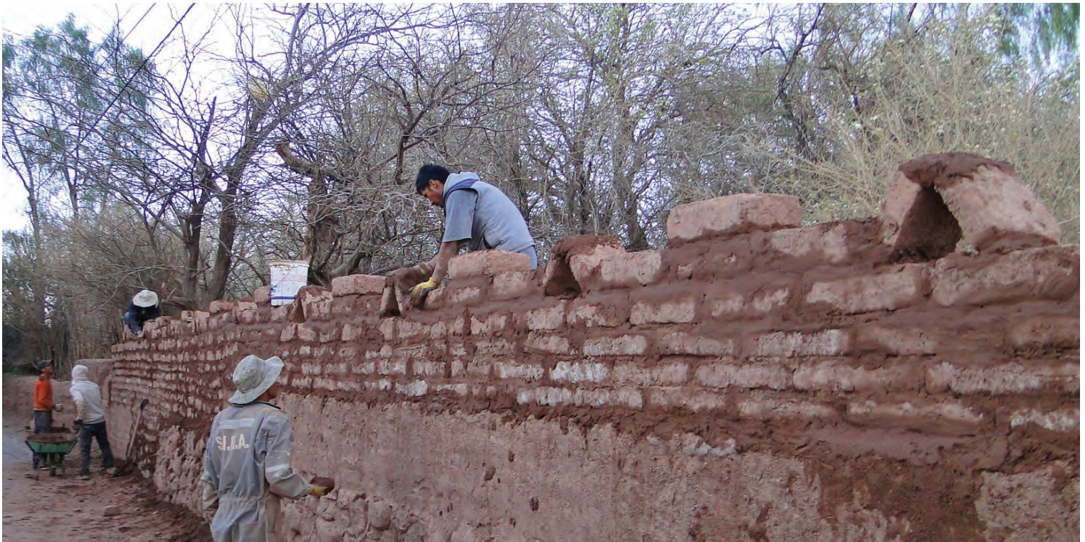
Muro de adobe | Adobe wall
