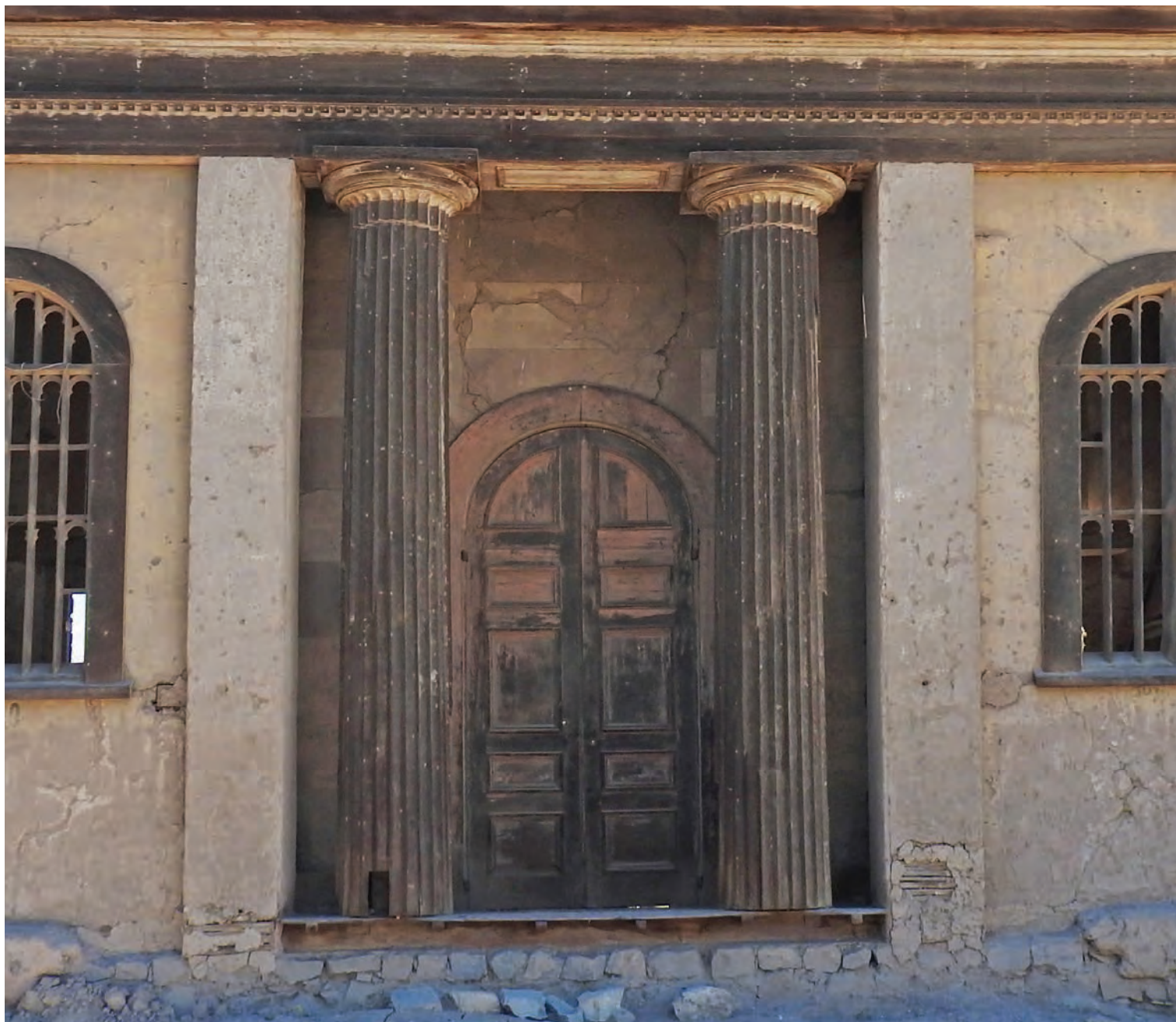
Pórtico de entrada | Entrance portico
