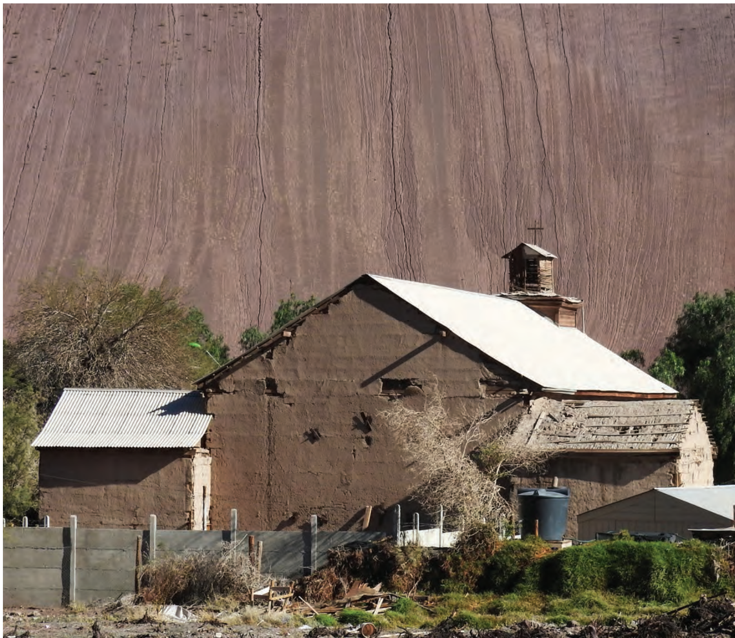
Fachada posterior de la Iglesia de San Antonio | Back facade of the church of San Antonio
