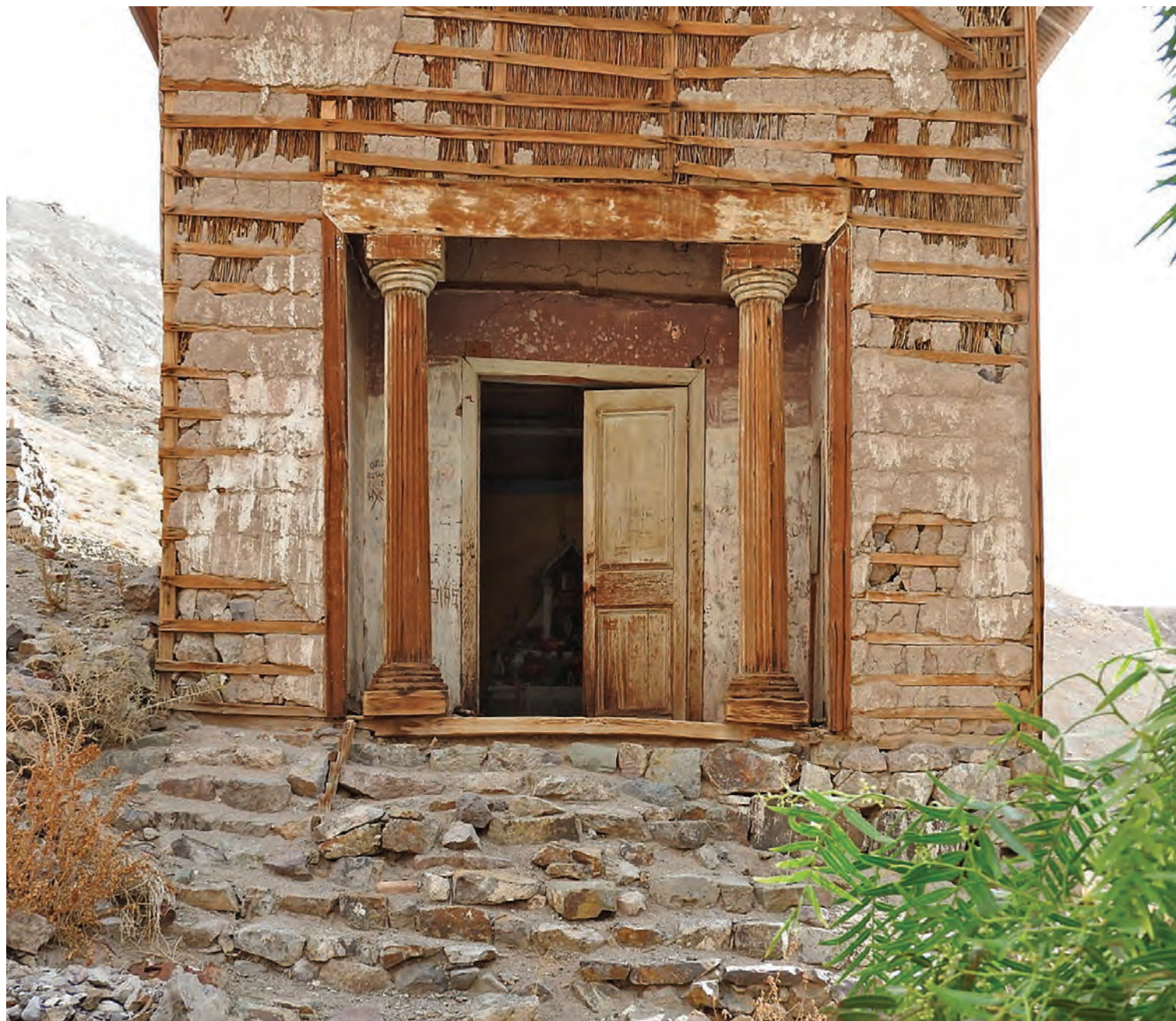
Pórtico de entrada | Entrance portico
