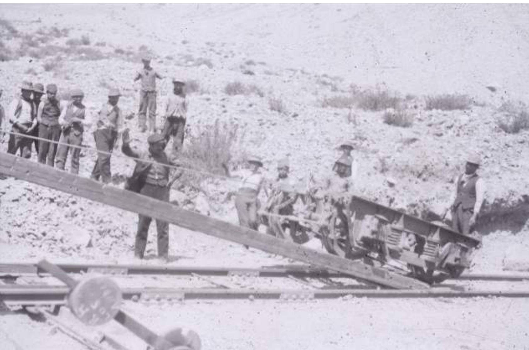
Fig 75. Faena de montaje de un boggie en las vías del FFCC Trasandino, posiblemente en el sector Juncal, 1920.
