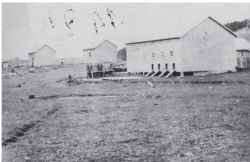
Fig. 07 - 08. Primeras construcciones en madera con tablas aserradas con sierra a brazo, tejuelas artesanales y madera labrada a hacha. Sector El Fraile, Coyhaique. c 1945.
