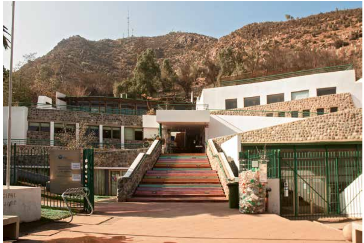
Exterior de Biblioteca Pública de Los Andes / Exterior of the Public Library of Los Andes.
