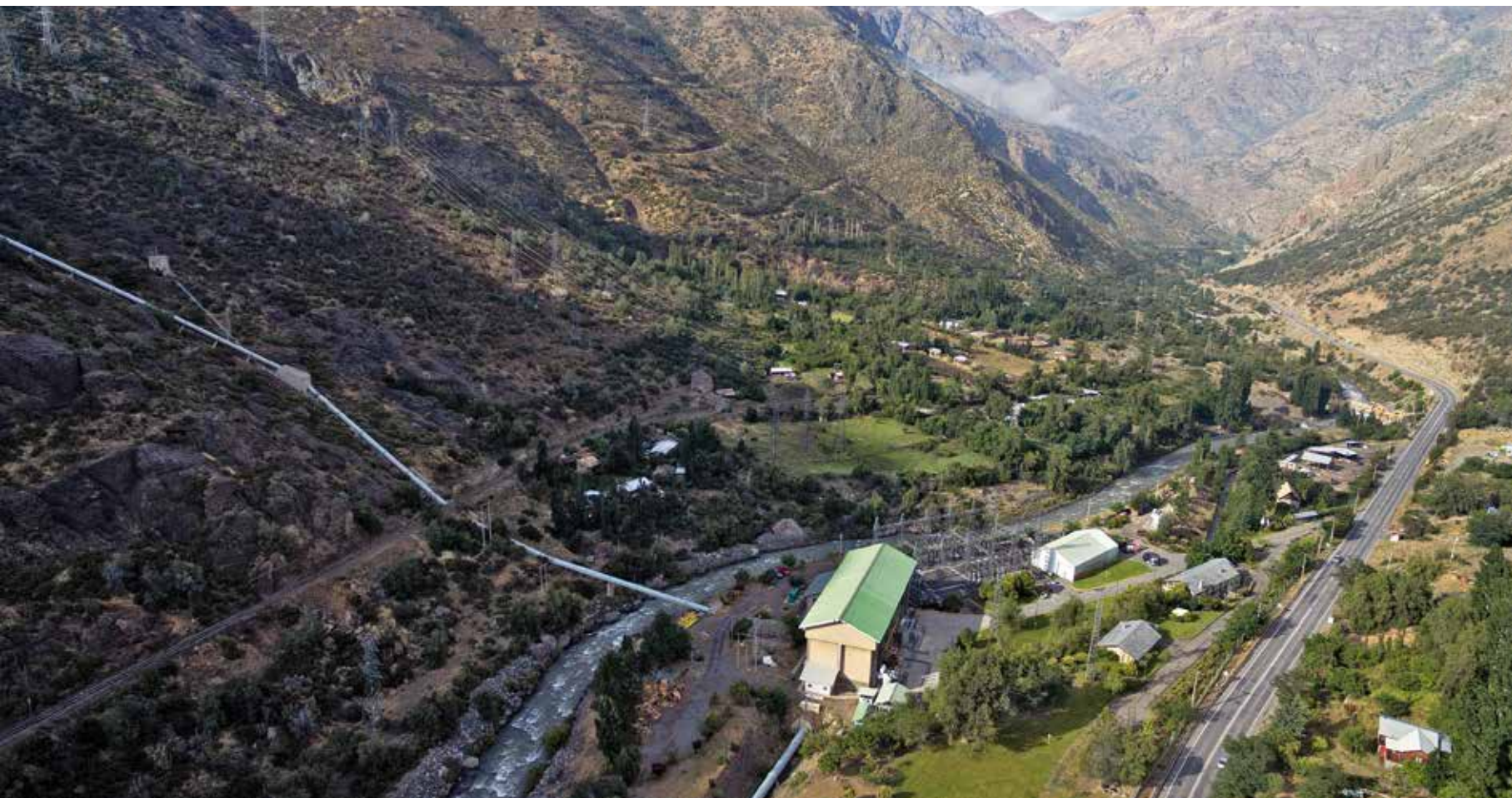
Central hidroeléctrica Aconcagua (Juncal y Blanco) / Hydroelectric power station Aconcagua (Juncal and Blanco).
