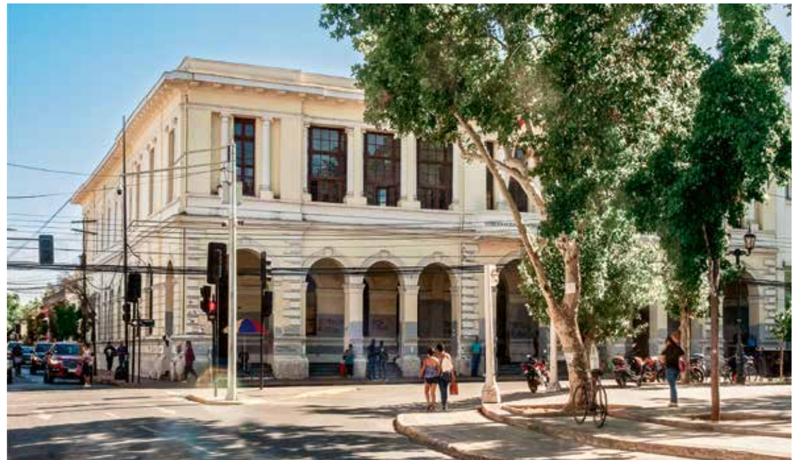
Edificio de la Gobernación / Building of the Governor's Office.
