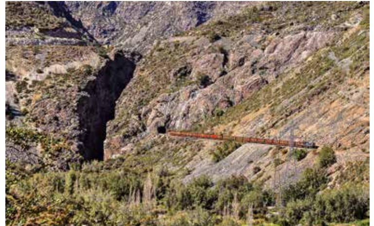
Túnel del Ferrocarril Trasandino en sector Salto del Soldado / Tunnel of the Trans-Andean Railroad in sector Salto del Soldado.
