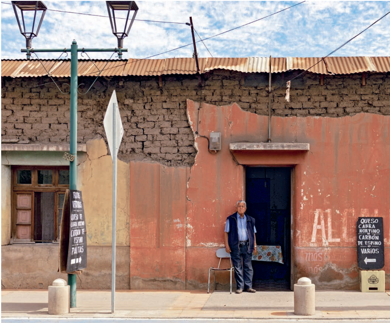
Fig. 41: Locales comerciales en el centro de Calle Larga, 2021.
