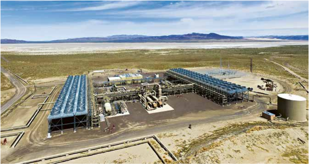
Planta híbrida geotérmica-solar de Enel en Stillwater (Nevada, Estados Unidos). Enel (USA).
