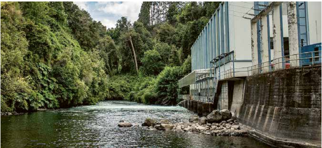
Central hidroeléctrica Pilmaiquén. Enel (Chile).
