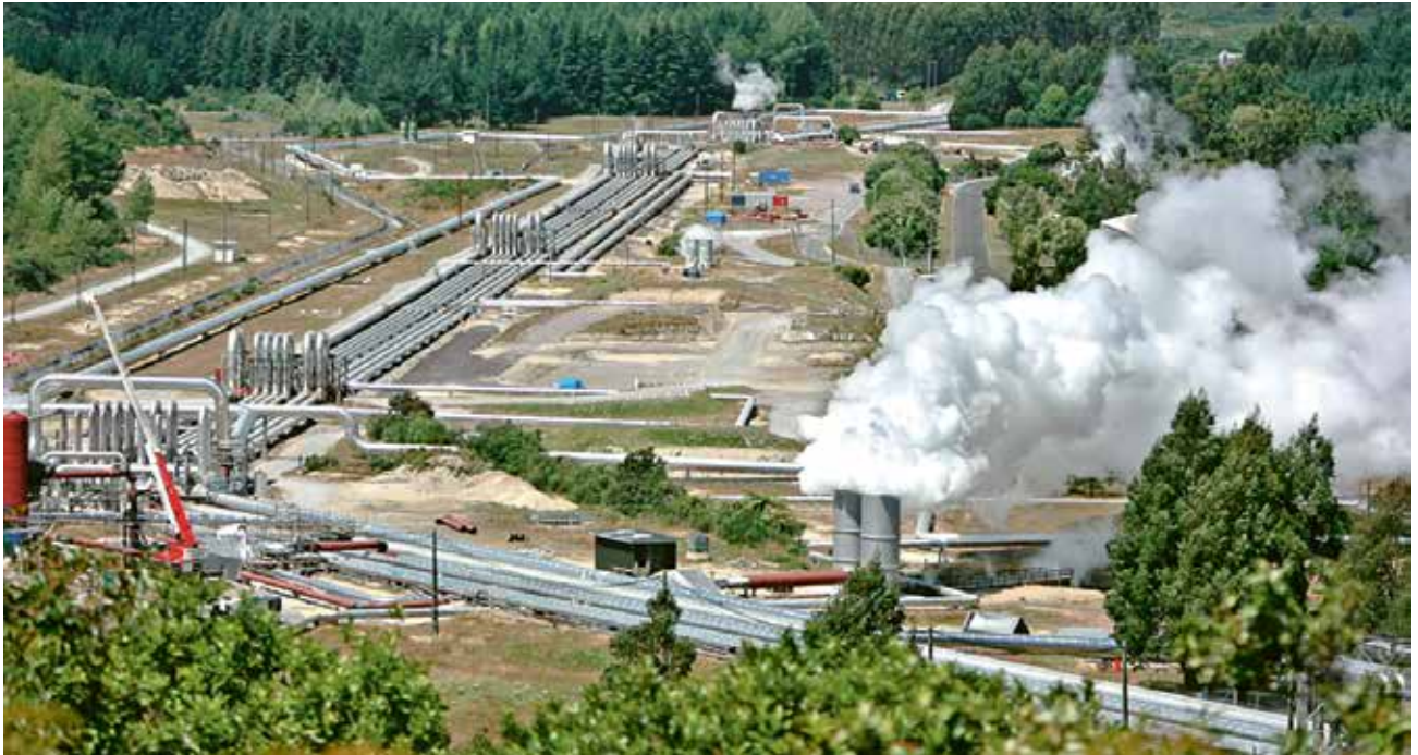
Planta geotermoeléctrica de Wairakei, en Nueva Zelanda.
