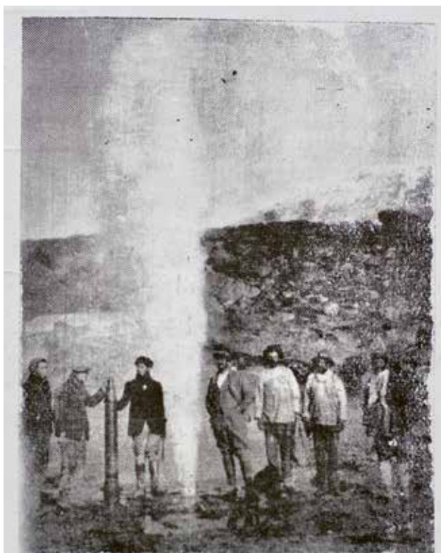
El soffione “18 de Septiembre” antes de la colocación del medidor de vapor
