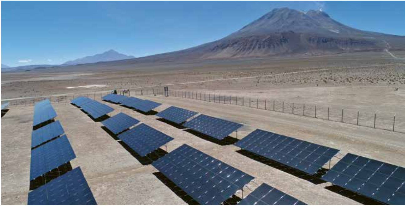
Paneles fotovoltaicos en el campamento de Cerro Pabellón. Enel (Chile).
