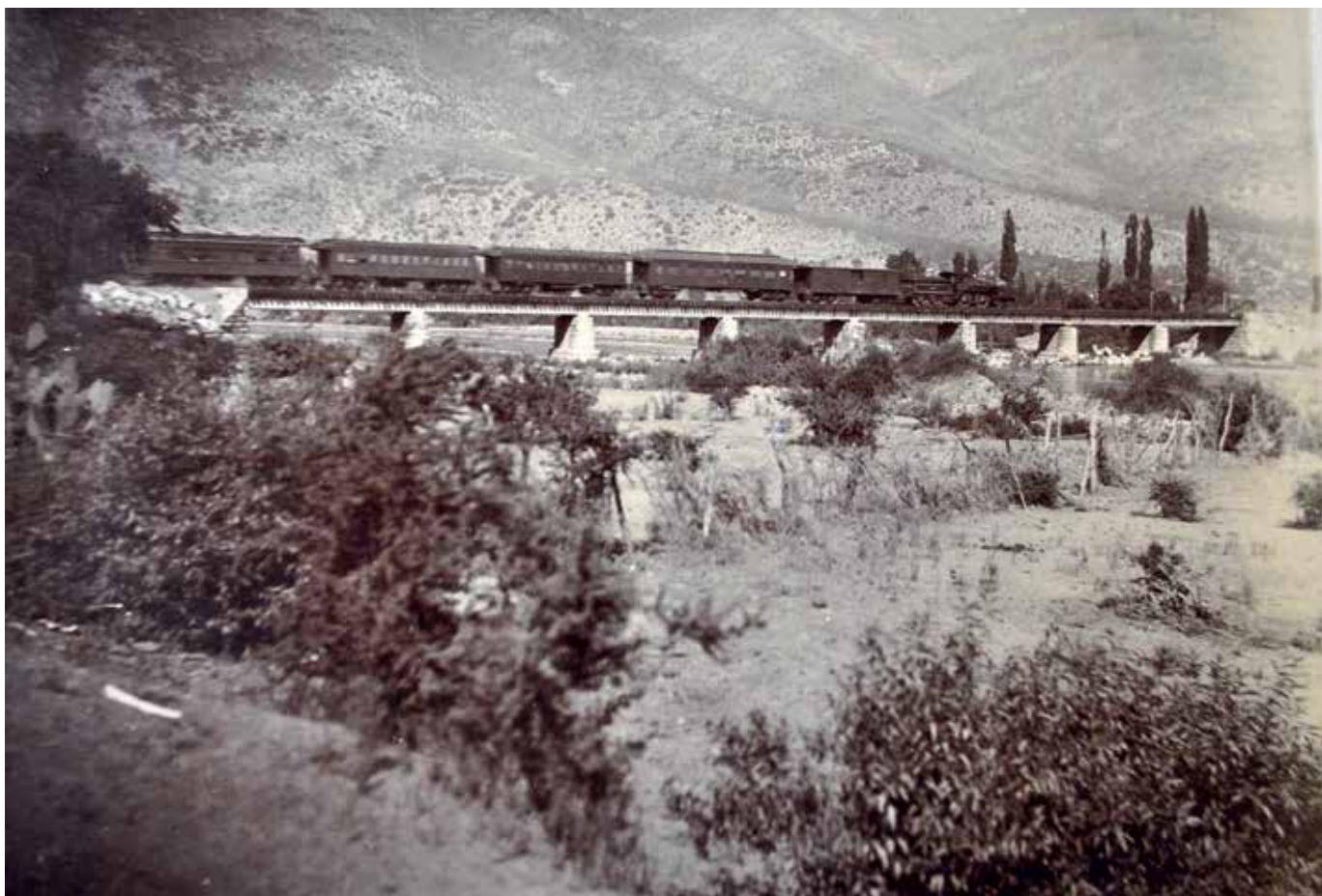
TÍTULO: Locomotora a vapor, carros de pasajeros sobre un puente construido sobre pilones de piedra PROPIETARIO: Familia Gillet Donoso AÑO: ca.1940 LUGAR: Polpaico
