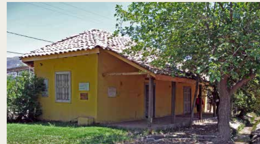
TÍTULO: Vista hacia la fachada posterior antigua casa de Domingo Fausino Sarmiento AUTOR: Marcelo Mella PROPIETARIO: Marcelo Mella AÑO: 2016 LUGAR: Calle Larga
