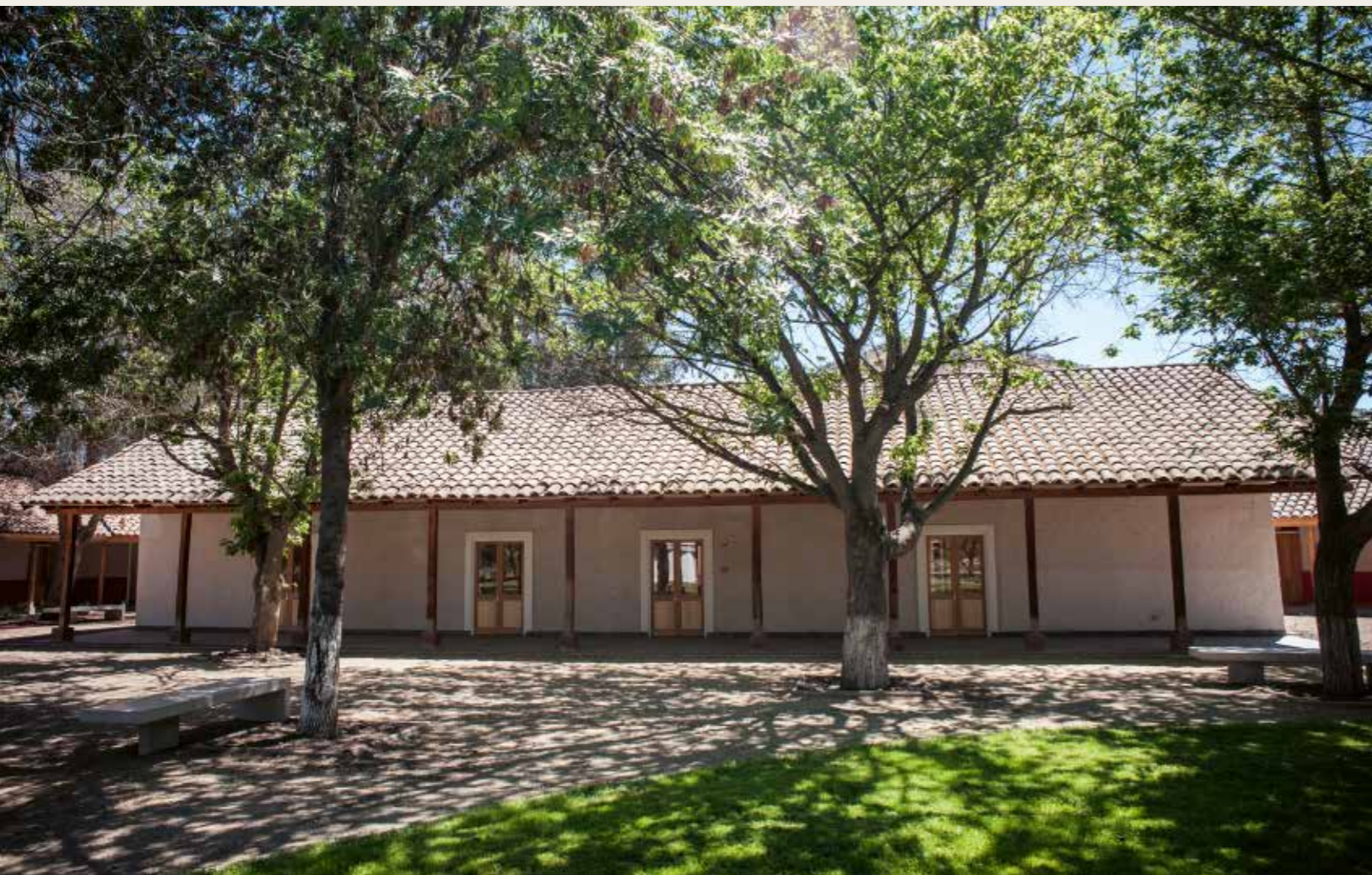
TÍTULO: Vista hacia la fachada posterior de la antigua casa de Pedro Aguirre Cerda PROPIETARIO: Centro Cultural y Casa Museo Pedro Aguirre Cerda AÑO: 2014 LUGAR: Pocuro, Calle Larga
