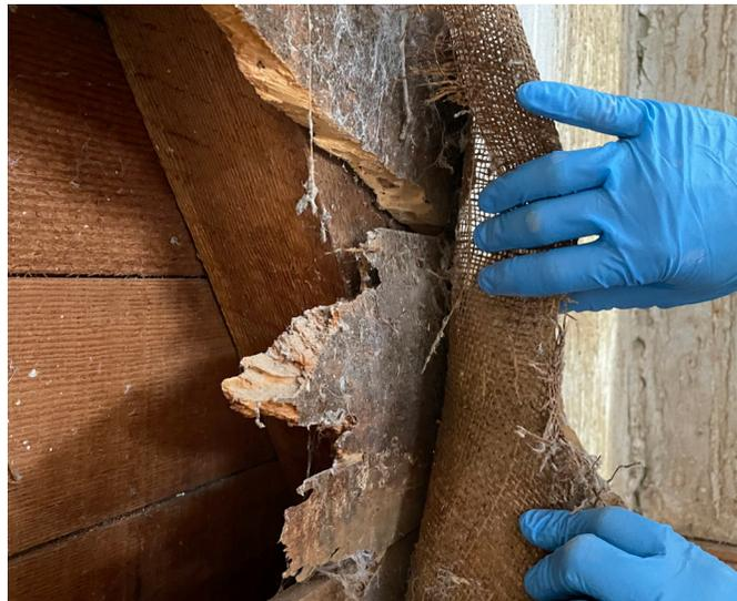
En cuanto a la terminación interior, se observa la utilización de tela arpillera para la adherencia y sujeción del papel mural. Respecto a la terminación exterior, cabe señalar que el inmueble posee un sistema mixto, conformado por la utilización de una malla metálica fija a los pies derechos y sobre ella, placas prefabricadas de concreto, conformándose así, una cámara intermedia de aire que favorece al desempeño energético de la edificación.
