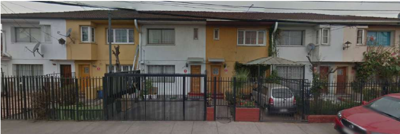
Fig. 09 Conjunto de viviendas Población CCU
