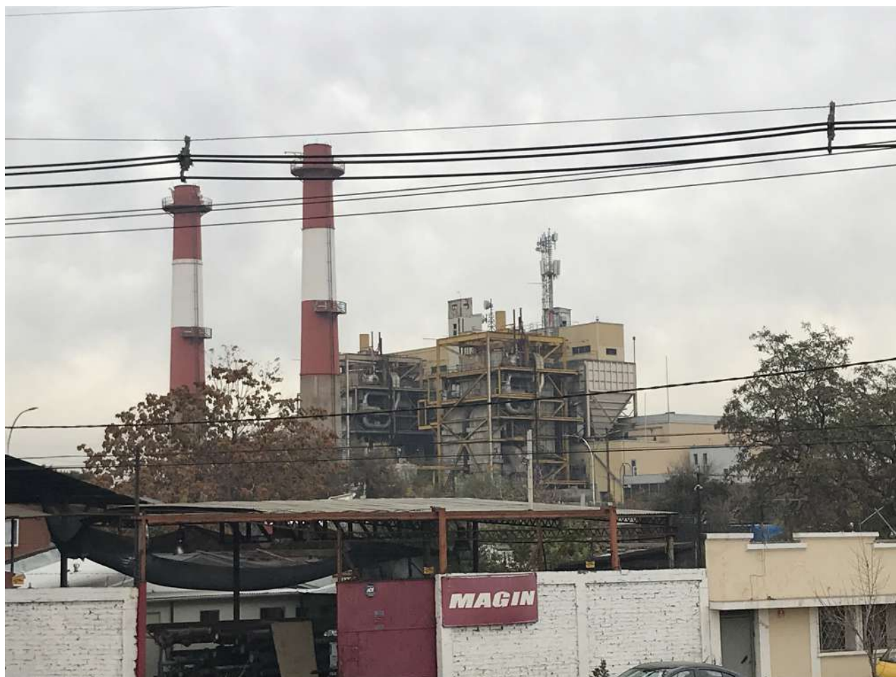
Fig. 26 Termoeléctrica de Renca
