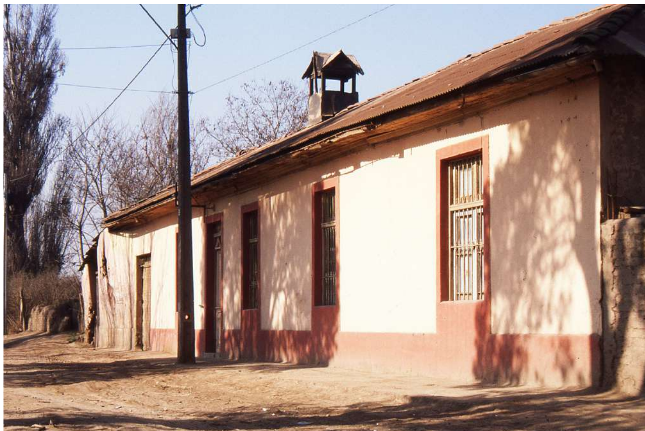
Fig. 01 Vista del barrio El Perejil
